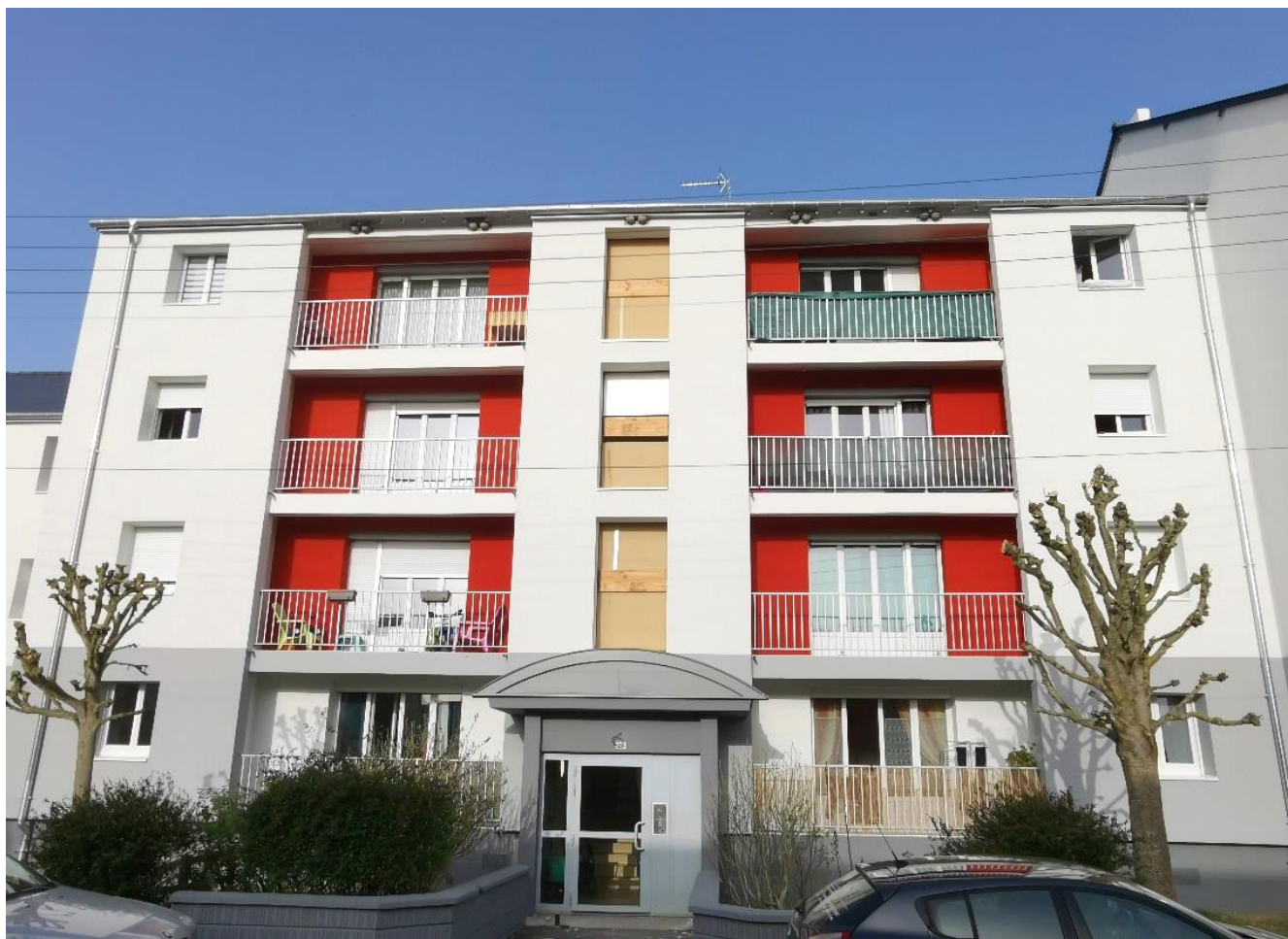
Figure 5. Nichoirs installés au 26 rue des Cèllets.
