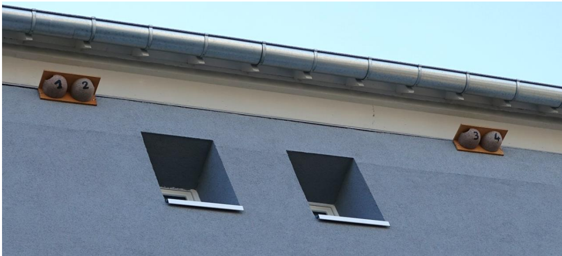
Figure 3. Nids artificiels numérotés installés sur la façade ouest au 2 rue Le Gobien.
