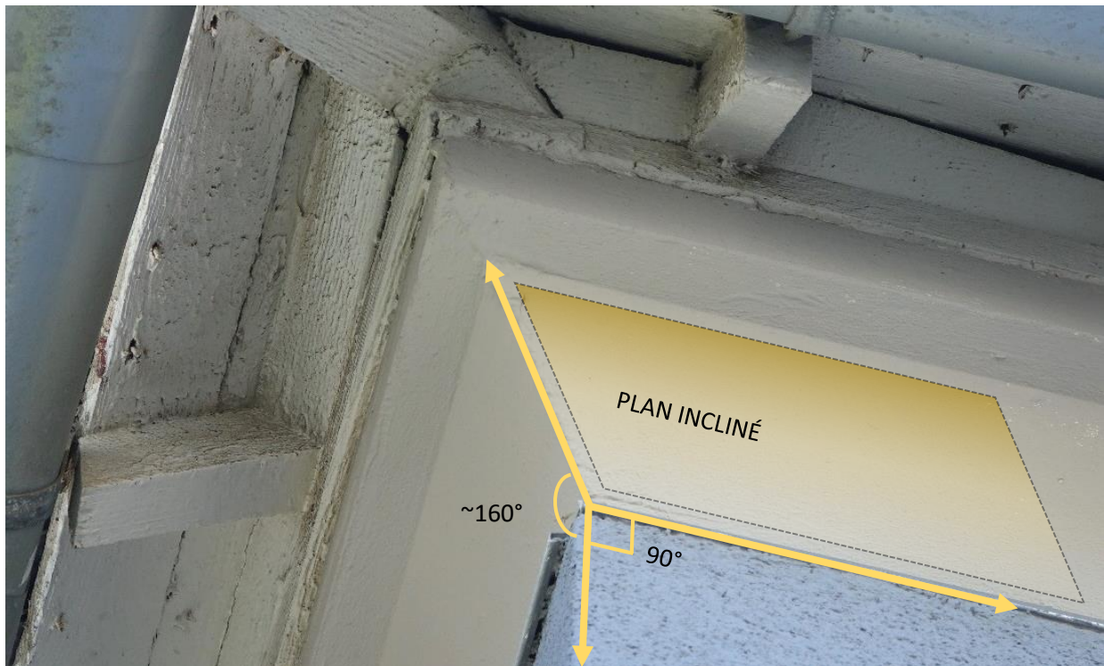
Figure 6. Plan incliné empêchant l'installation satisfaisante des nids artificiels.
