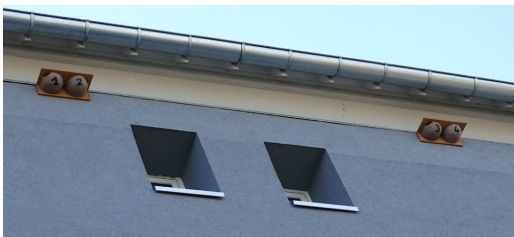
Figure 4. Nids artificiels numérotés installés sur la façade ouest au 2 rue Le Gobien.
