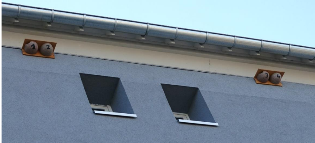
Figure 7. Nids artificiels numérotés installés sur la façade ouest au 2 rue Le Gobien.
