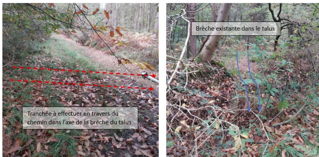
Figure 48 : Schéma de principe du basculement des écoulements en travers du chemin
