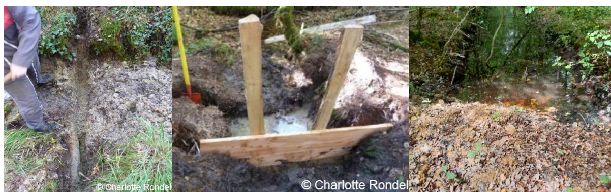
Figure 30 : Schéma des étapes de réalisation d'un bouchon étanche
