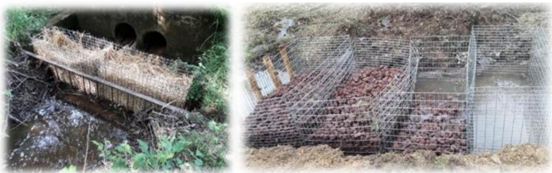
Figure 41 : Photographie d'un dispositif filtrant à paille (gauche) ou à gabion (droite) en aval d'un chantier
